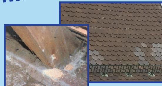
Beschädigte Dachbalken und alte, bereits abrutschende Dachtaschen
